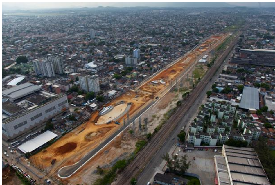
Figura 9 - Parque urbano sendo construído em Madureira
